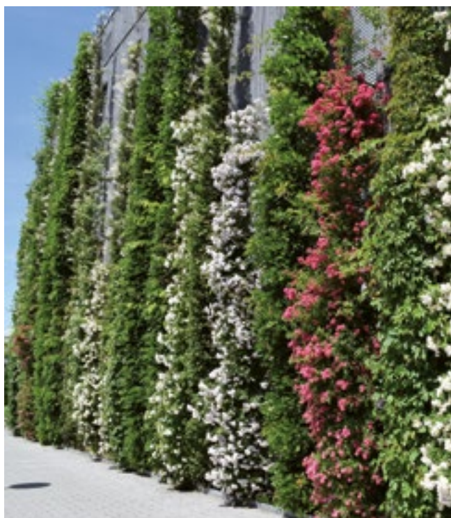
25 Beispiel für eine bodengebundene Fassadenbegrünung
