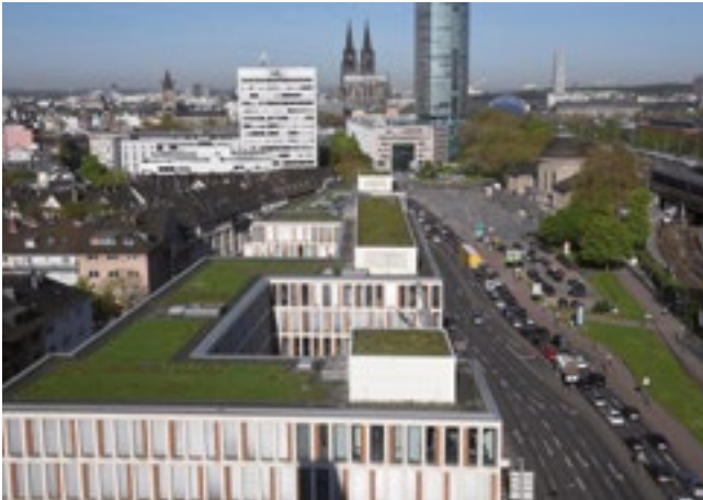
21 Dachbegrünung in Köln
