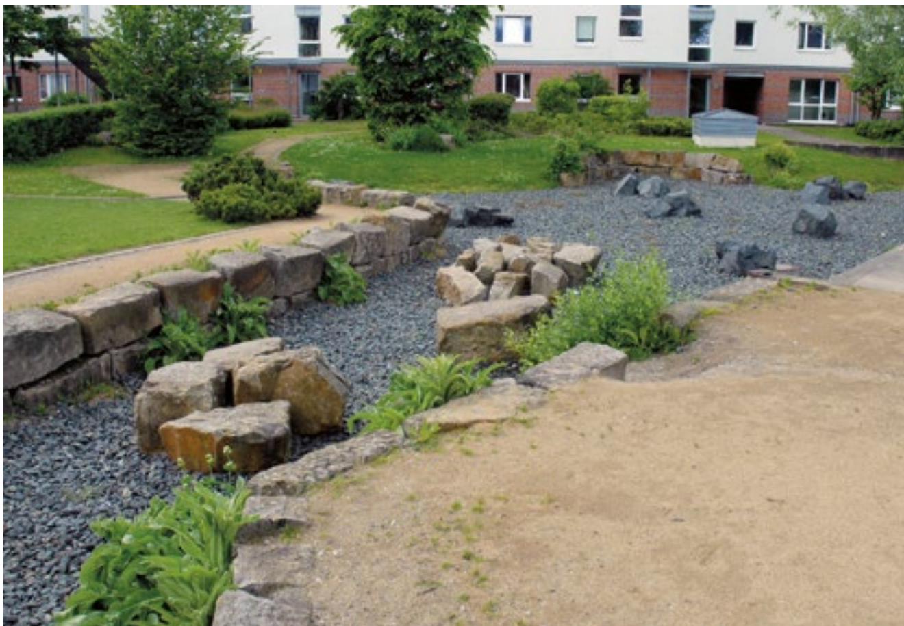
35 Dezentrale Regenwasserbewirtschaftung in einem Hinterhof
