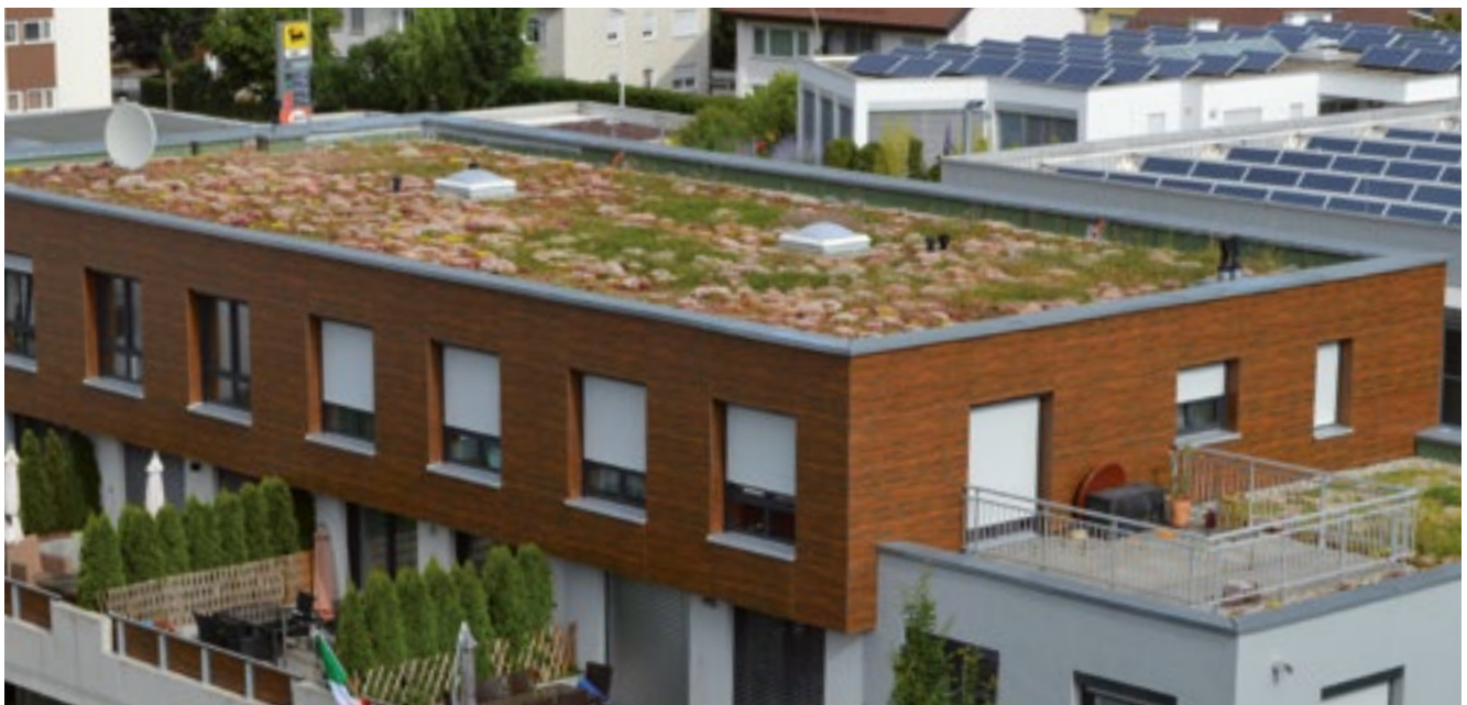
17 Dachfläche mit Extensivbegrünung
