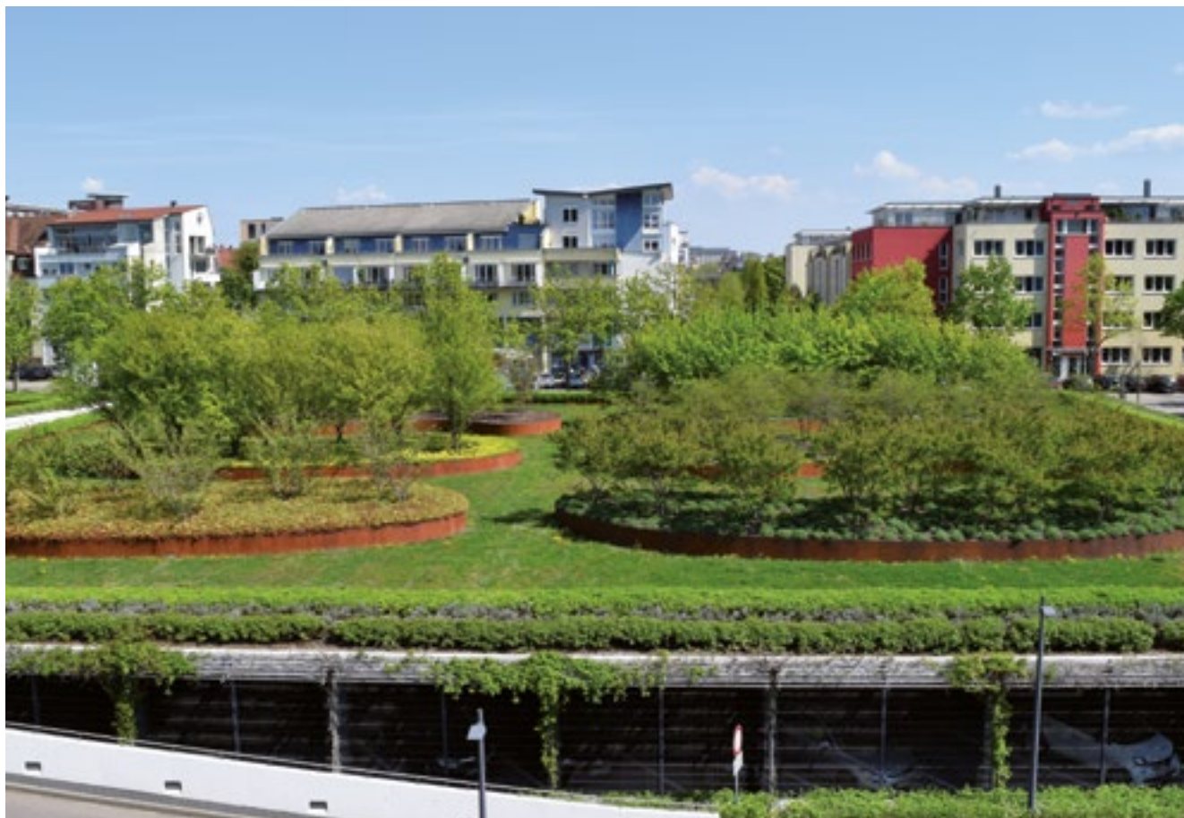
15 Intensivbegrünung einer Tiefgarage
