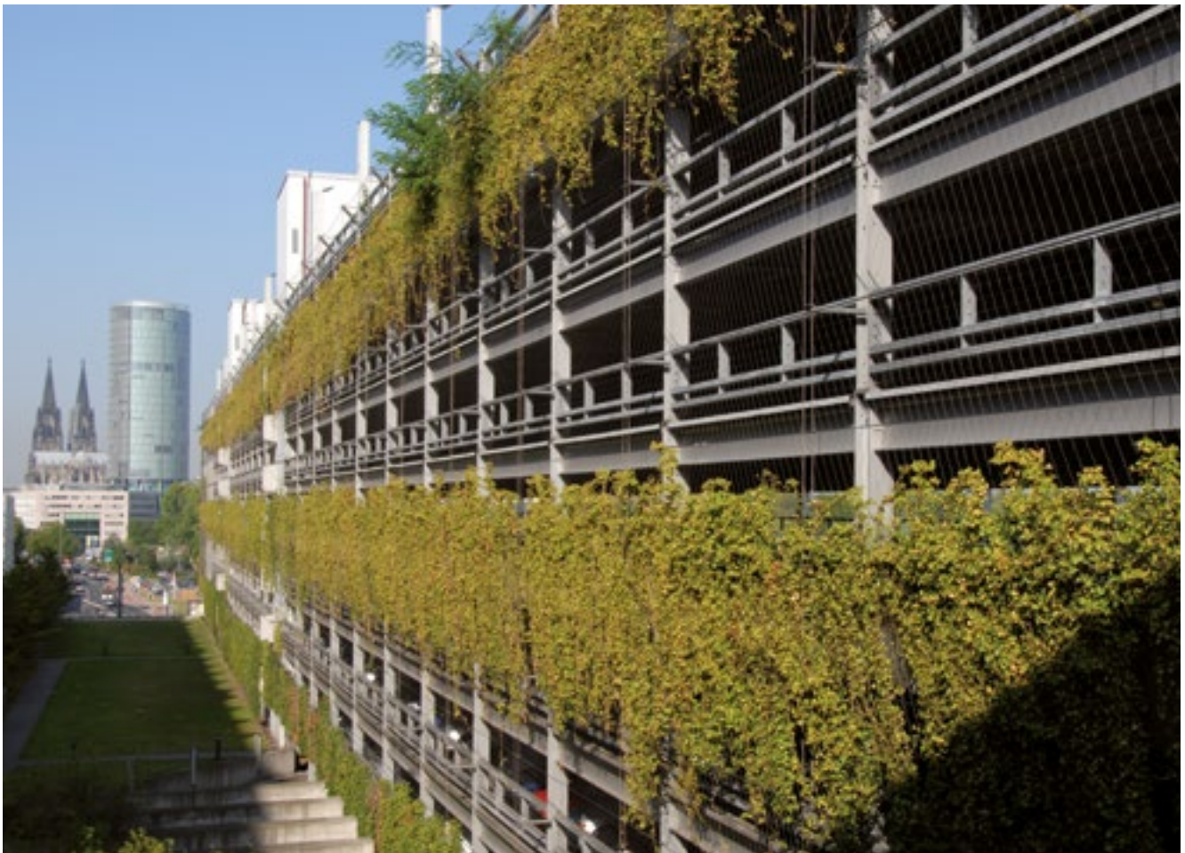
33 Beispiel einer Fassadenbegrünung an einem Parkhaus
